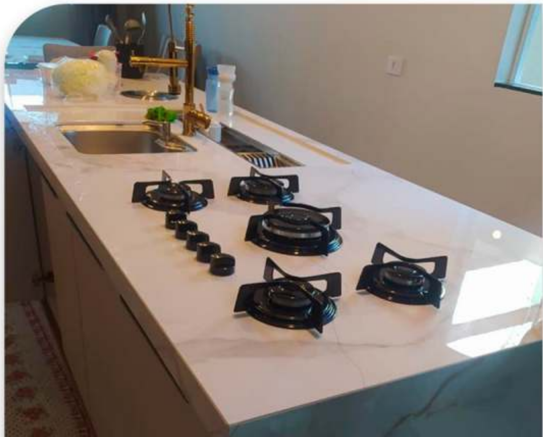
Instalação de Cooktop convencional
